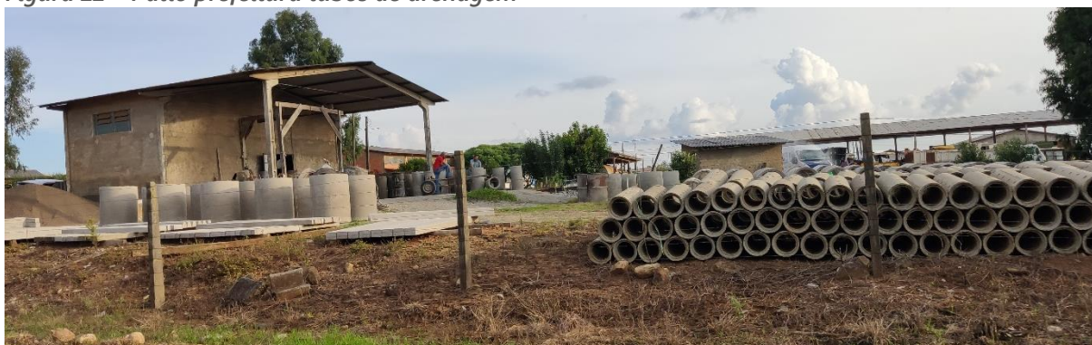
Figura 22 – Pátio prefeitura tubos de drenagem
