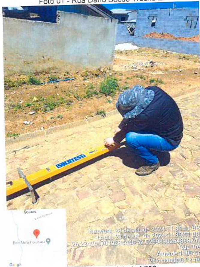
Foto 02 - Rua Projetada N°06
